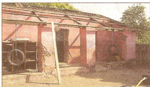
Das Waisenhausgebäude wird renoviert
